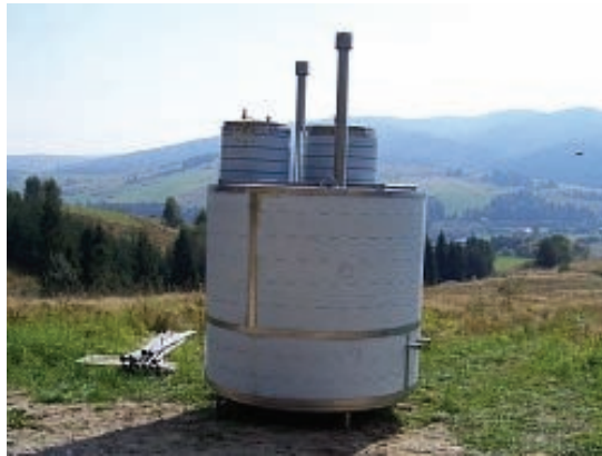
Rysunek 15. Obudowa kompaktowa stosowana w ujęciach należących do „Multivita” – widok ogólny przed zamontowaniem (fot. „Deiter” sp. z o.o)
