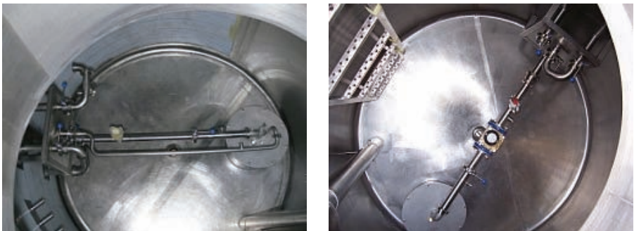
Rysunek 16. Obudowa kompaktowa stosowana w ujęciach należących do „Multivita” – widok wnętrza obudowy (fot. „Deiter” sp. z o.o)
